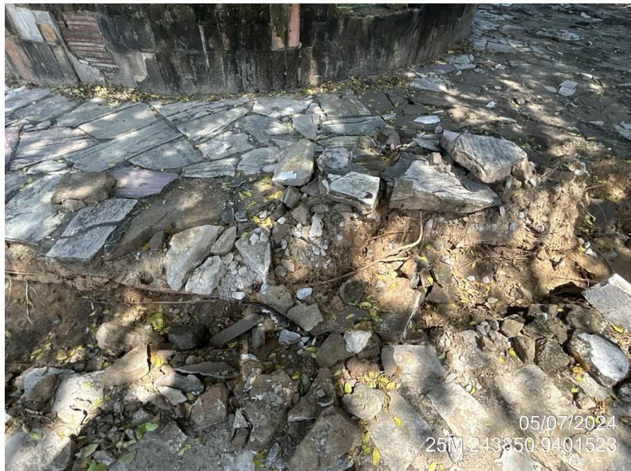
Figura 04: Indicativo de danos ao passeio da praça pública, ocasionado pelo afloramento do sistema radicular de *Azadirachta indica*. 05/07/2024. Coordenadas UTM 25M 243850 9401523.
